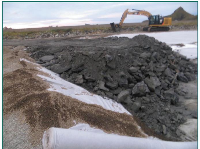
Detalj fra deponering i 2013. Legging av fiberduk. Foto: Kystverket
